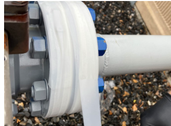
Step 3: Wrap the flange with ZIF Tape.
